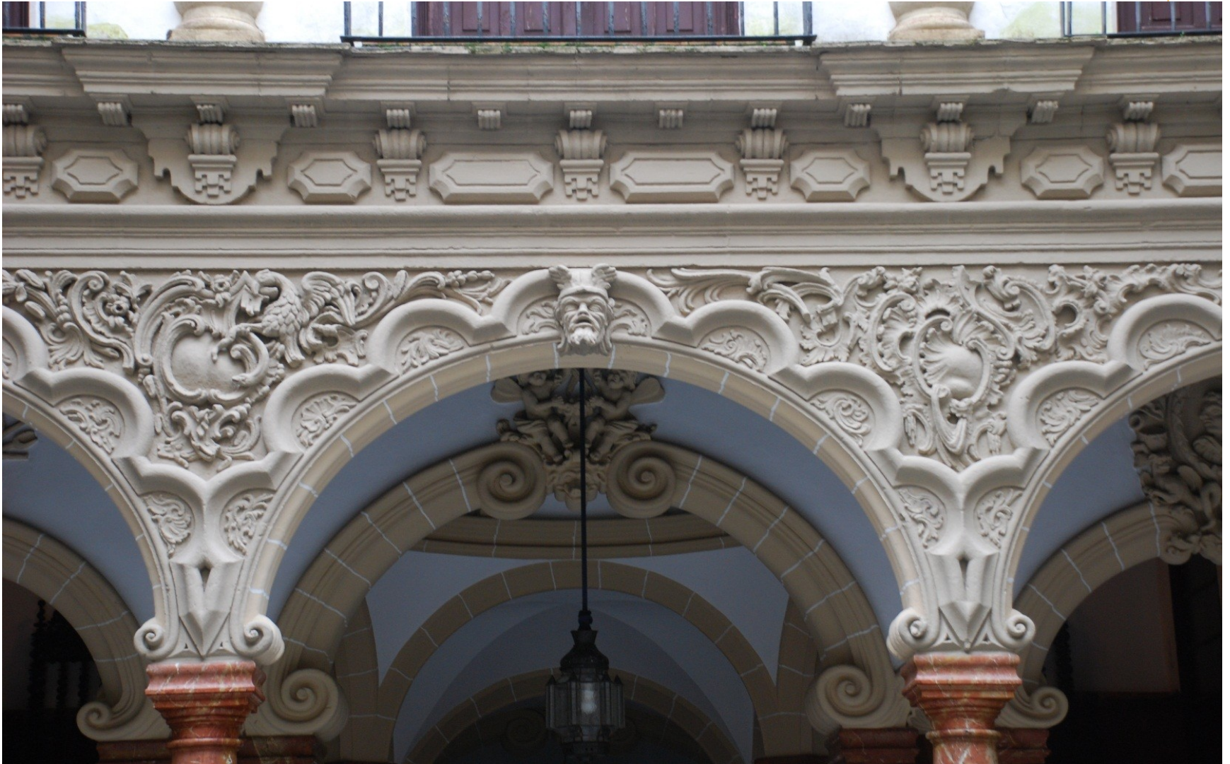
Ansicht der Rokokoornamente des Innenhofes
