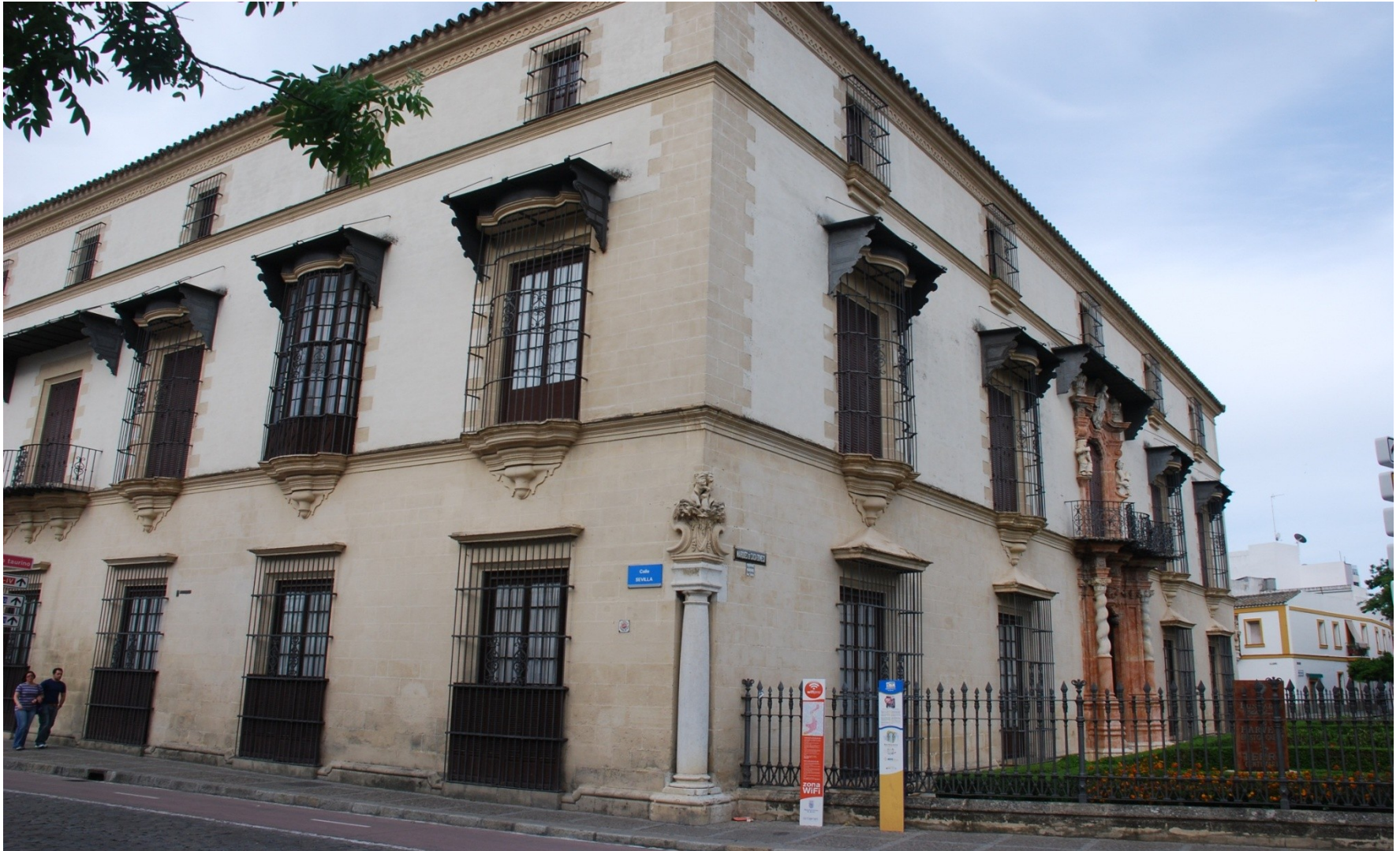
Haupt- und Seitenfassade
