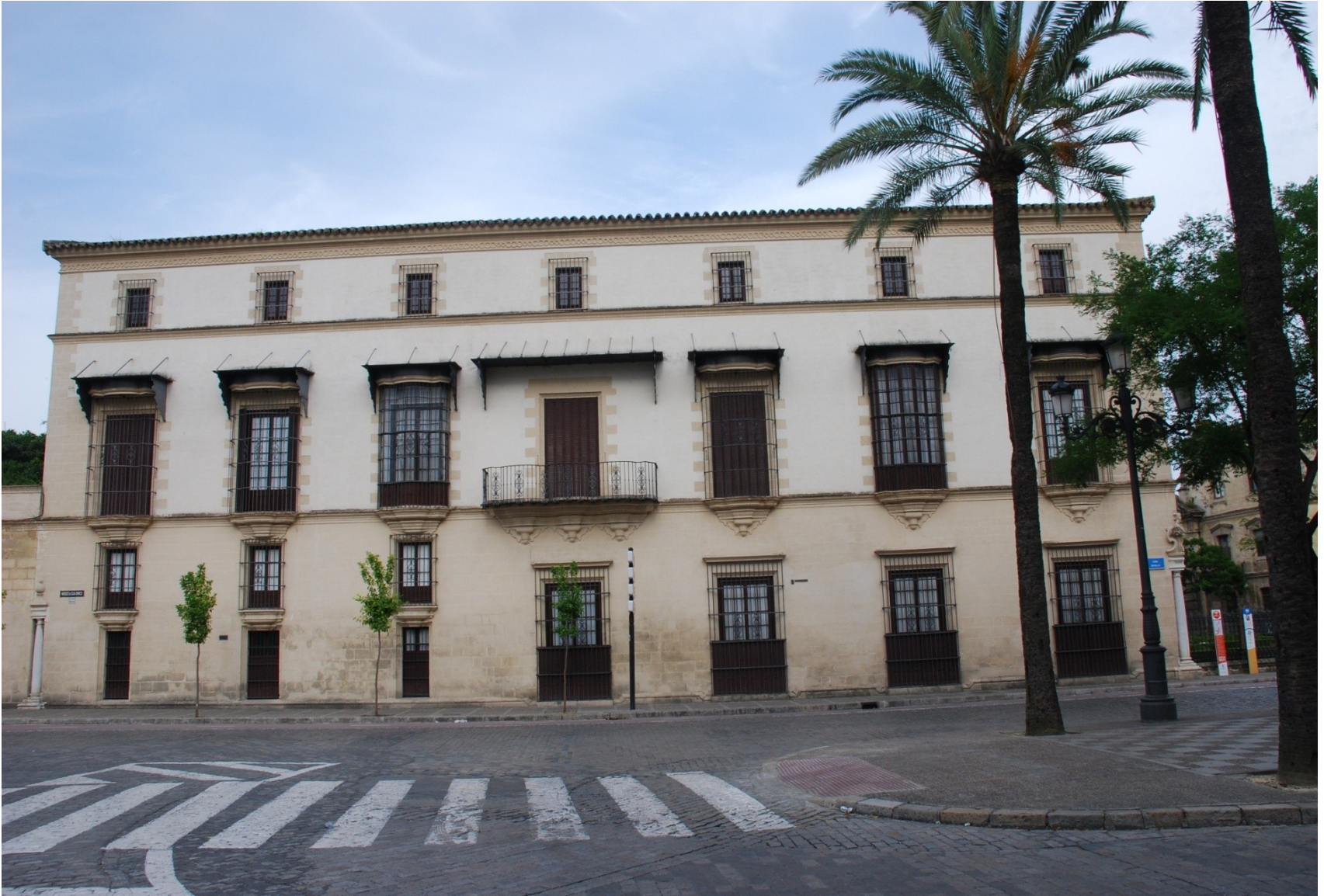
Seitenfassade des Palasts
