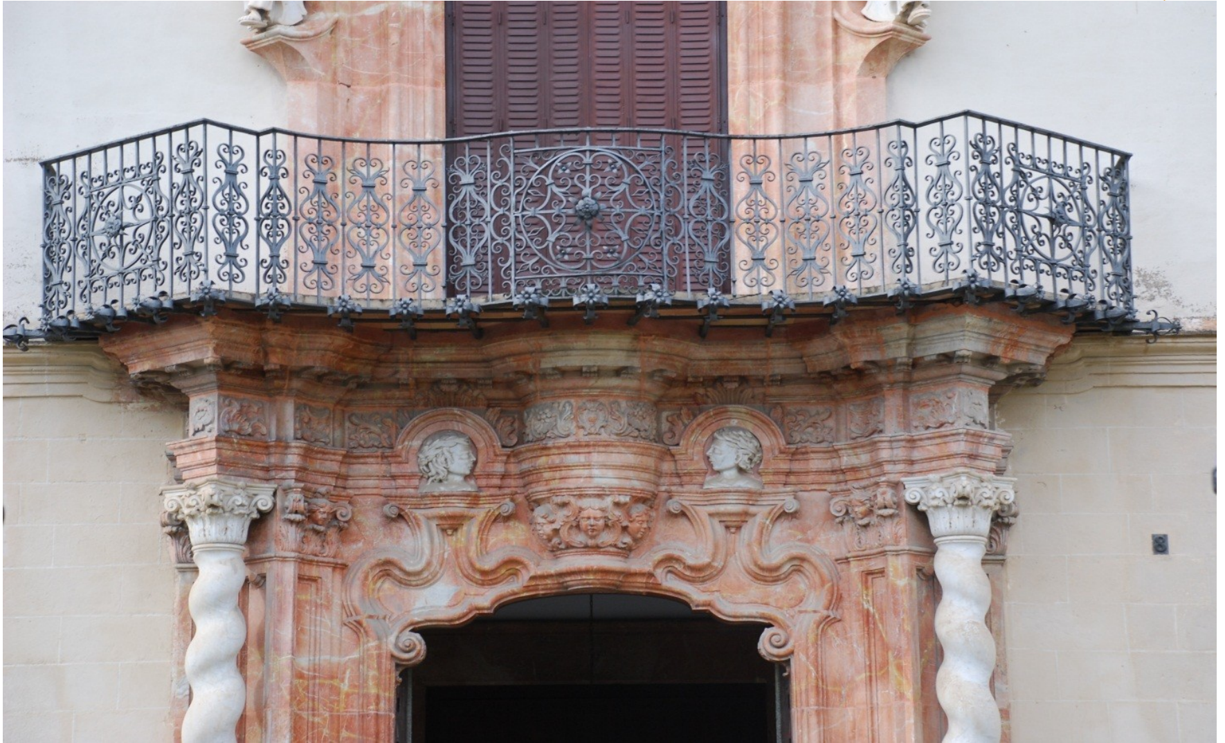
Balkon über dem Hauptportal
