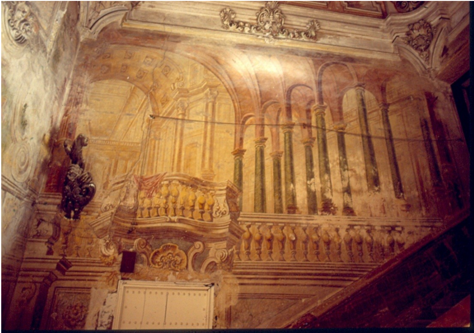
Ausschnitt der Wandgemälde mit vorgetäuschten Gebäuden neben der Treppe
