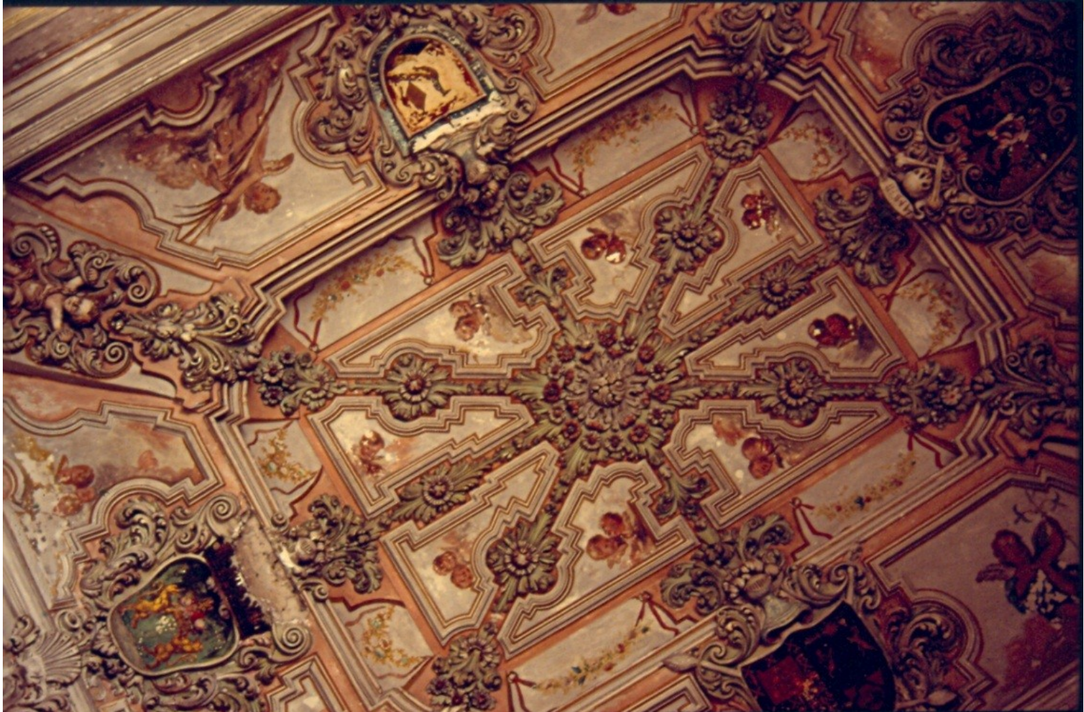
Ausschnitt des Flachgewölbes über der Treppe
