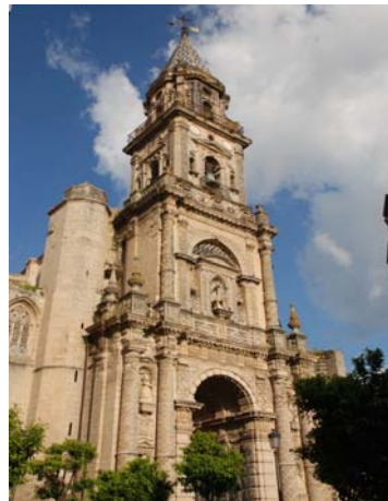
Parroquia de san Miguel, Torre-fachada / Kirche San Miguel, Frontseite des Glockenturms
